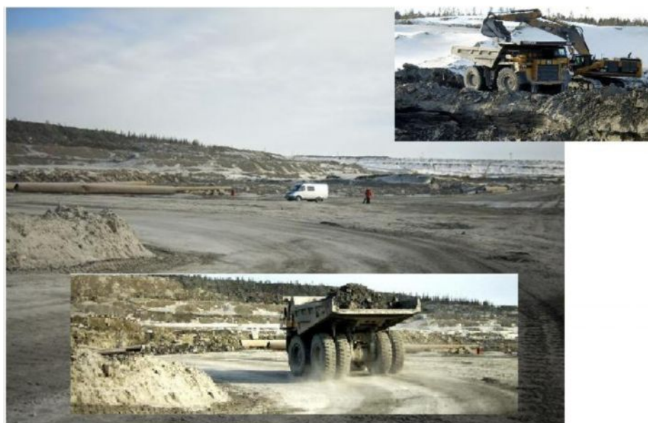
Рисунок 2 – Отработанное хвостохранилище отходов МОФ
