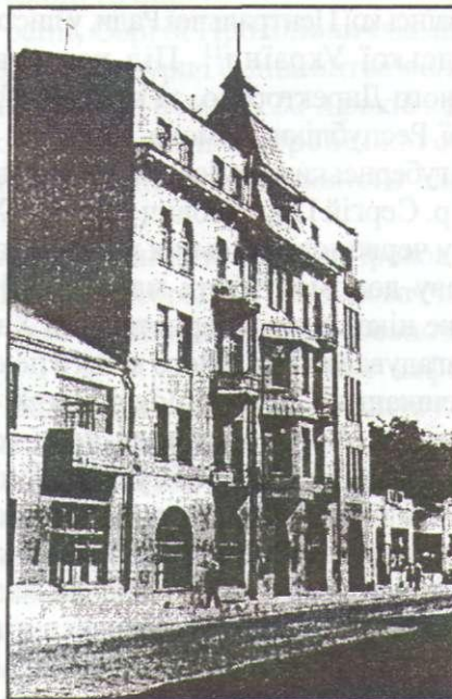
Будинок, зведений за проектом С.П.Тимошенка на початку ХХ ст. Нинішня вул.Полтавський шлях. Харків
