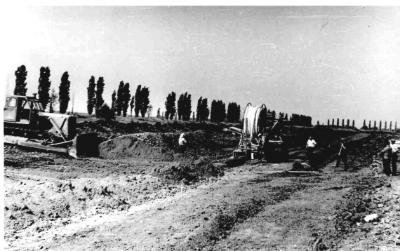
Рис. 6. Укладка дренажа траншейным дреноукладчиком
