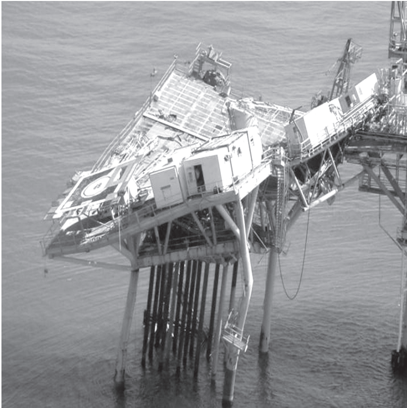
Рис. 1. Последствия воздействия штормовых волн и ветра в урагане «Лили» на буровую платформу в Мексиканском заливе
