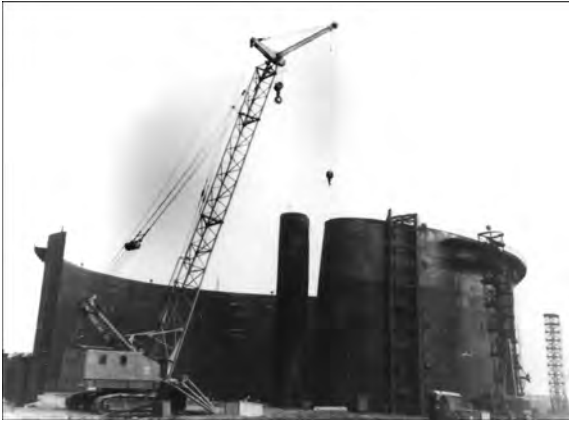
Рис. 3. Сооружение резервуара вместимостью 50 тыс. м 3 из сварных рулонных заготовок (1974 г.)
