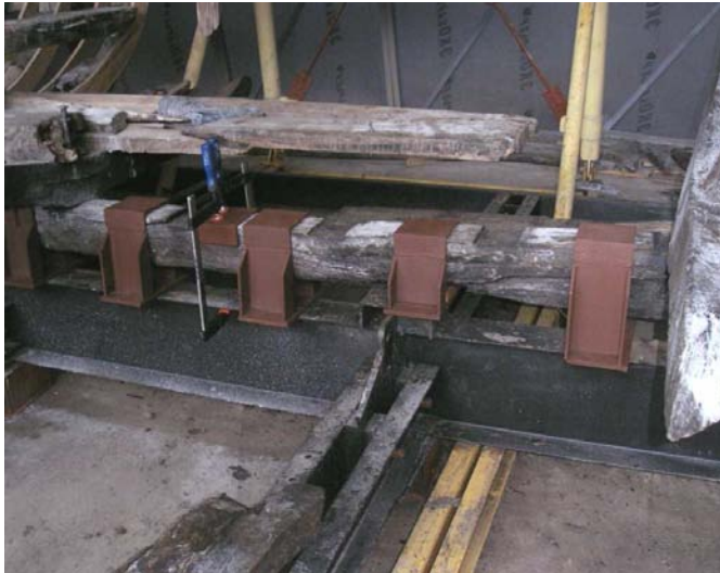
Фото 2. Установка кільових вузлів
