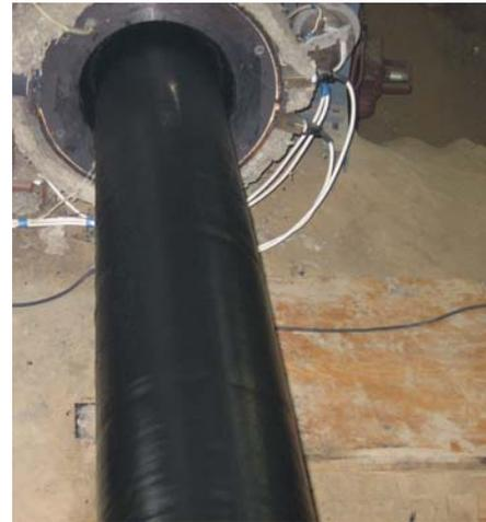
Рис. 2. Нанесение покрытия
