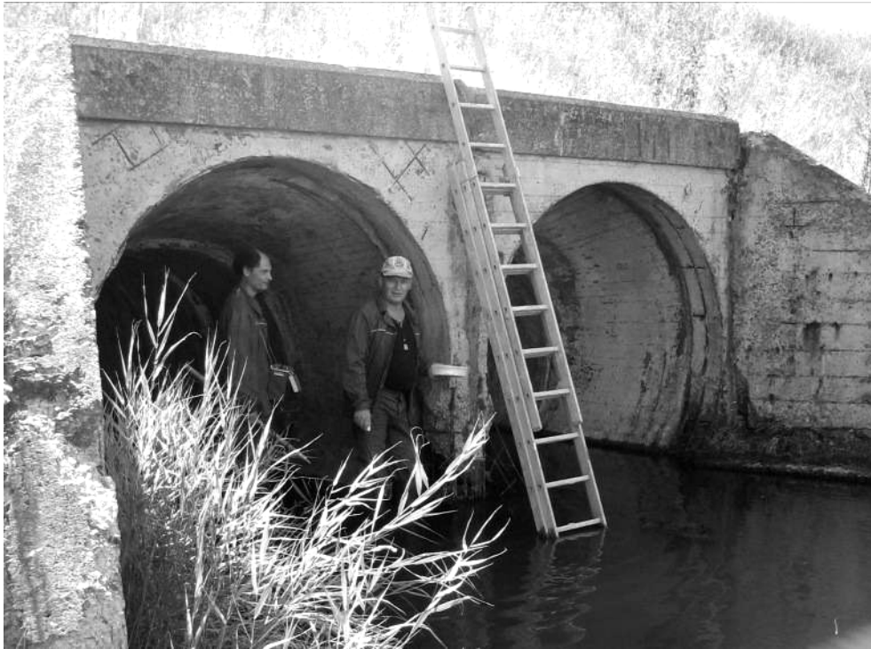
Рис. 1 – Внешний вид водосбросного сооружения со стороны выходного оголовка
