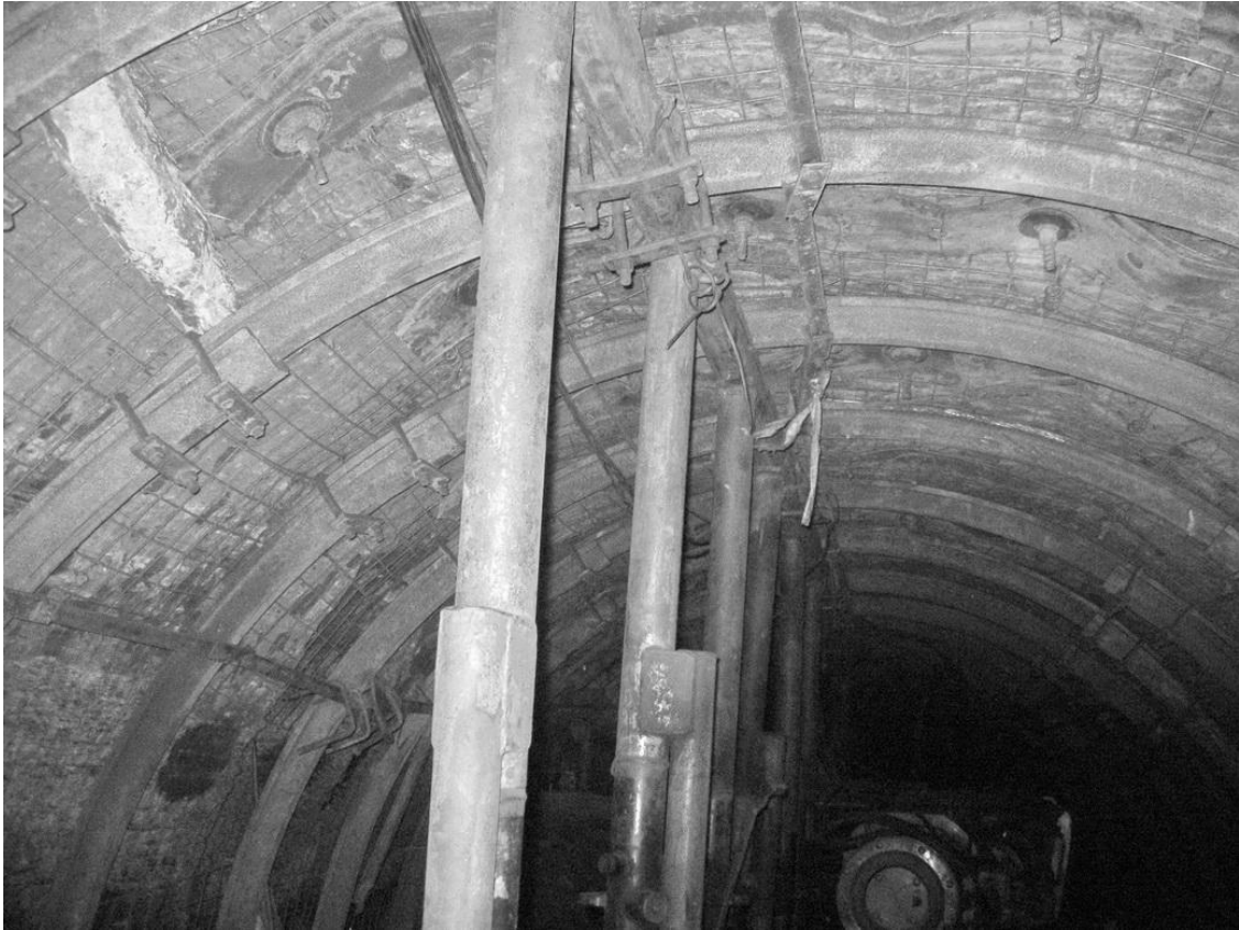
Рис. 3 – Стан 413 бортового штреку на вікні лави
