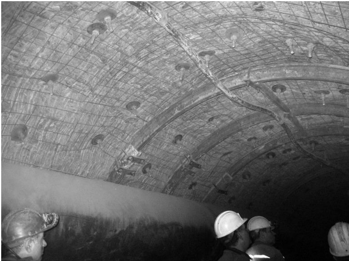
Рис. 2 – Стан 413 бортового штреку у проходці
