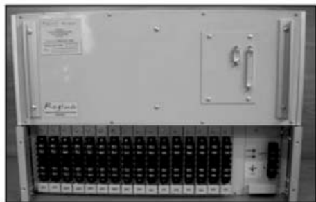
Рис. 9. Апаратура для моніторингу перехідних режимів (МПР) в Об'єднаній енергосистемі України (ліворуч знизу). Карта першої черги розміщення в Україні засобів МПР на енергооб'єктах 330—750 кіловольт (праворуч)
