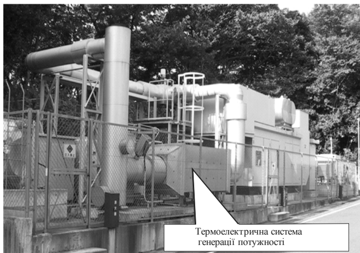
Рис. 1. Демонстраційна випробувальна установка класу 1кВт, встановлена в системі сумісного генерування тепла й електрики від дизельного двигуна 500 кВт.
