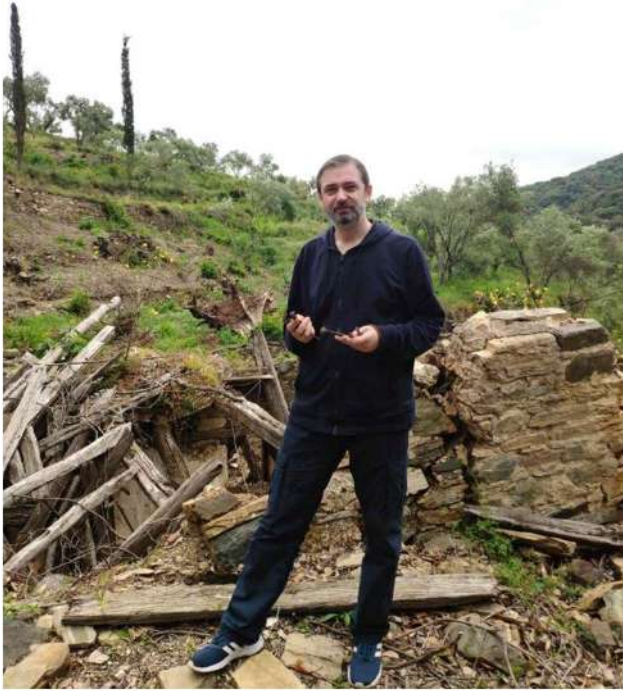
С. Шумило біля руїн каливи «Кіпарі» («Кипарис») після вирубки та розчистки території. Травень 2023 р.
