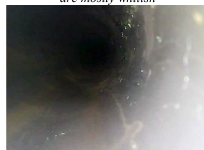
Fig. 7. Upper horizontal pipe
