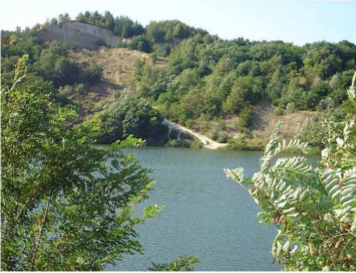
Рис. 1. Зсув на березі Канівського водосховища
