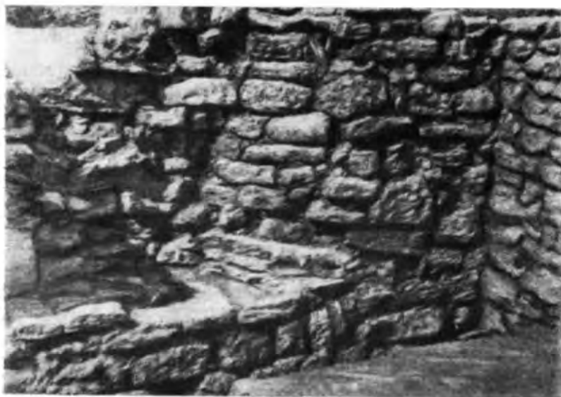
Рис. 13. Будівля з нішею. Загальний вигляд ніши.
