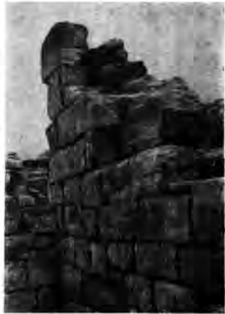
Рис. 9. Громадська будівля. Кладка стін підвального приміщення № 3.
