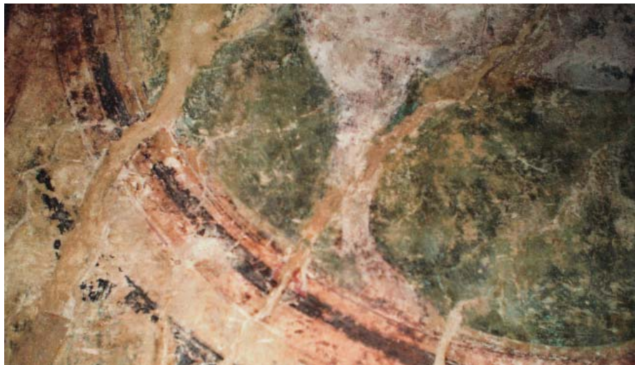
Рис. 5. Широкая бурая трещина, пересекающая фреску с изображением осла, «разрывает» правую заднюю ногу и смещает ее нижний фрагмент (фото автора)
