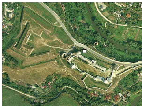
Рис. 1. Місце обвалу стіни
