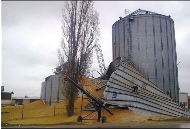
Рис. 1. Аварія сталевго силосу для зберігання зерна
