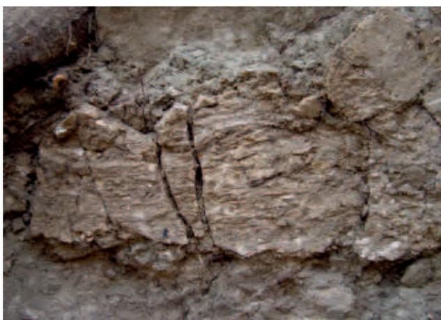
Рис. 1.35. Остатки известковой штукатурки со следами затирки поверхности травой.
