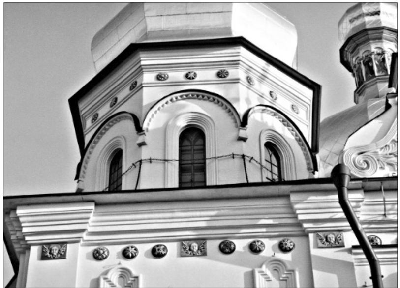
Рис. 4. Низки керамічних полив'яних розеток на північному фасаді та бічній бані відбудованого Успенського собору лаври. Фото автора
