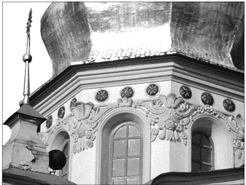
Рис. 5. Керамічні розетки на барабані купола Троїцької надбрамної церкви Києво-Печерської лаври. Знімок Д. Фінадоріної
