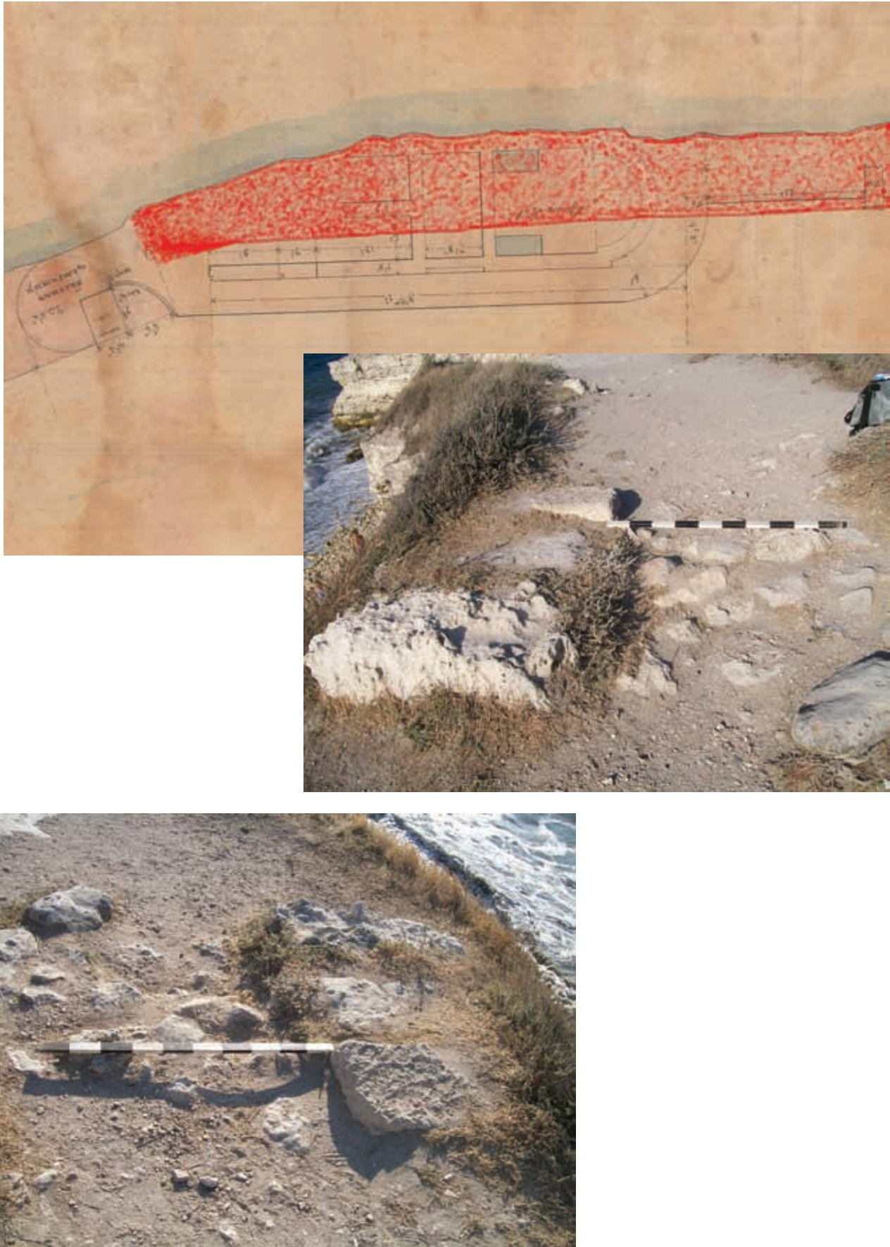
Рис. 10. Утрата береговой полосы и архитектурных деталей строений между Уваровской и Восточной базиликами.
