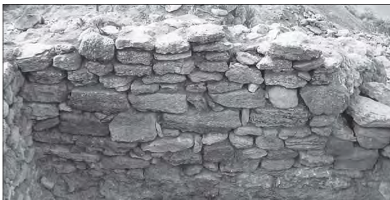
Рис. 5. Помещение А. Кладка 19 с севера.
