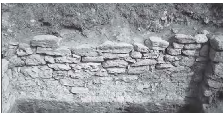
Рис. 7. Помещение А. Кладка 31 с юга.
