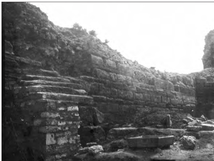
Рис. 10. Склеп № 1014 в процессе реставрационных работ.
