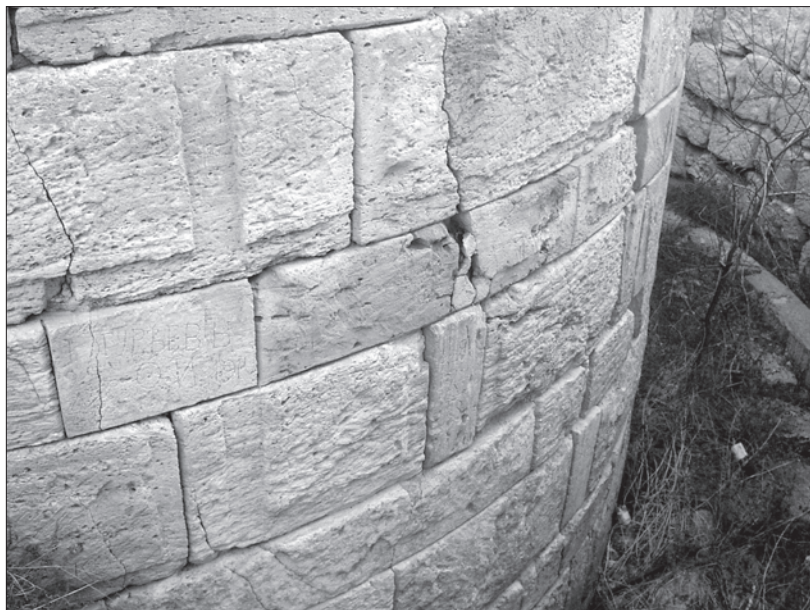
Рис. 13. Паз для вертикального выравнивания кладки (башня Зинона).
