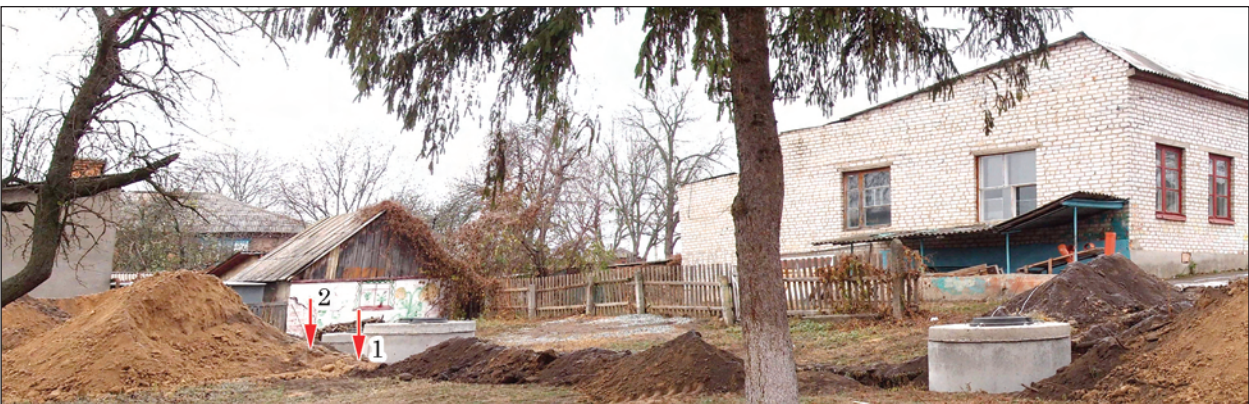
Рис. 6. Радомишль, 2019 р., садиба школи № 3, вид зі сходу на південно-західну частину траншеї: 1 — зачистка 2; 2 — об'єкт 3
