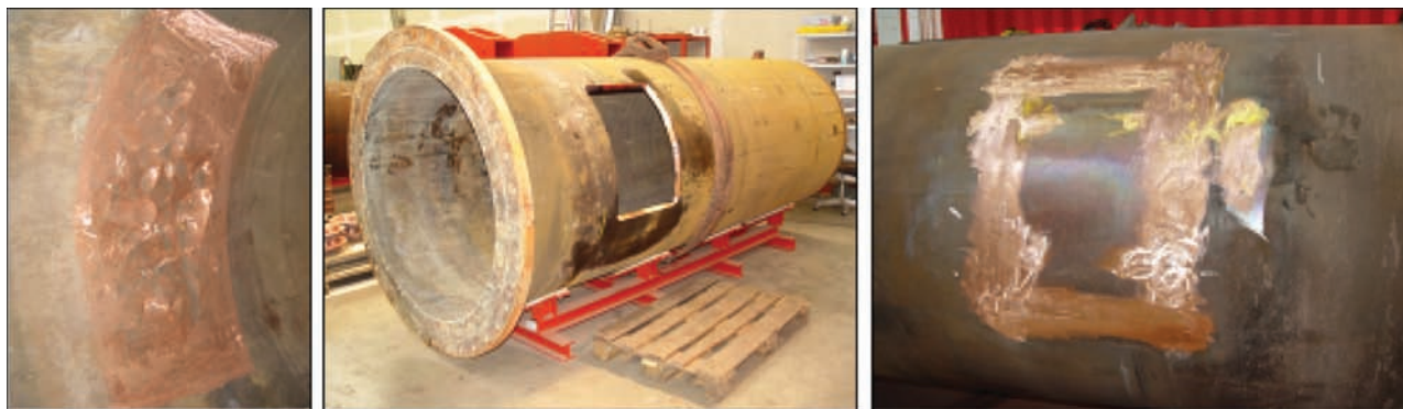
Рис. 17. Ремонт кокилей путем замены дефектных участков
