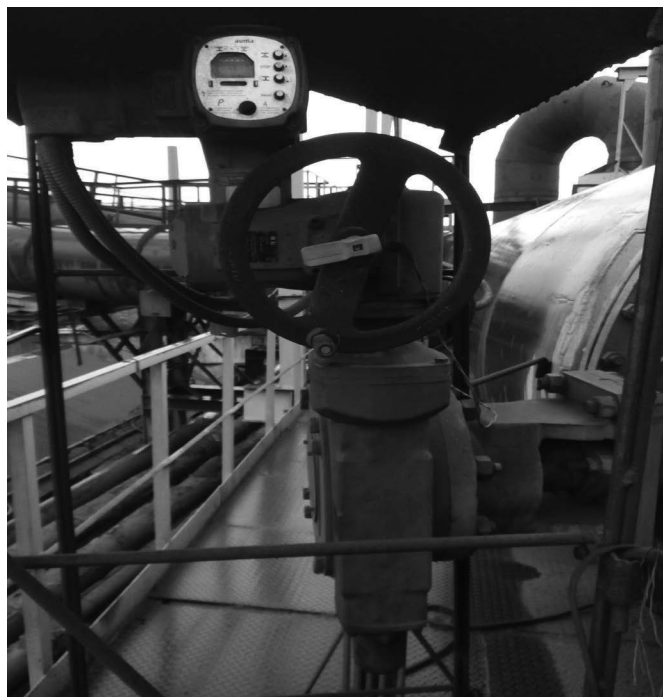
Рис. 4. Автоматически регулируемый запорный клапан объединенной комплексной системы пылегазоудаления – ЭРТУМГ
