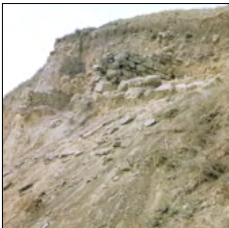
Рис. 21. Пункт 1-0. Общий вид с северо-востока с уровня ступенек в южной части п. 1
