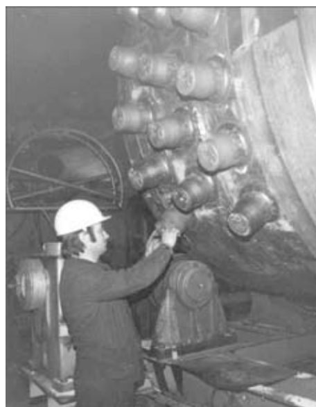
Рис. 1. Корпус сосуда высокого давления с выплавленными на его поверхности методом ЭШВ патрубками диаметром 160 мм
