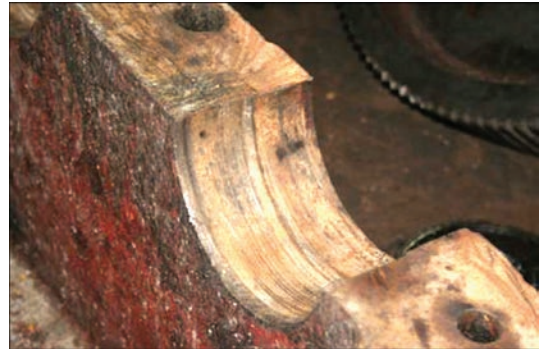
Рис. 4. Износ посадочных мест подшипников
