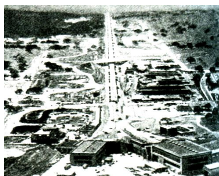
Рис. 5. Общий панорамный вид сверху на Станфордский сверхмощный линейный ускоритель электронов (США) с их выходной энергией до 21 ГэВ [1]
