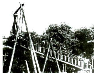
Рис. 7. Внешний вид ГИН на выходное напряжение 3,5 МВ для испытаний на молниестойкость воздушных ЛЭП "Донбассэнерго" (разработка ХЭТИ), построенный в полевых условиях на деревянных опорах в 1934 году [71]
