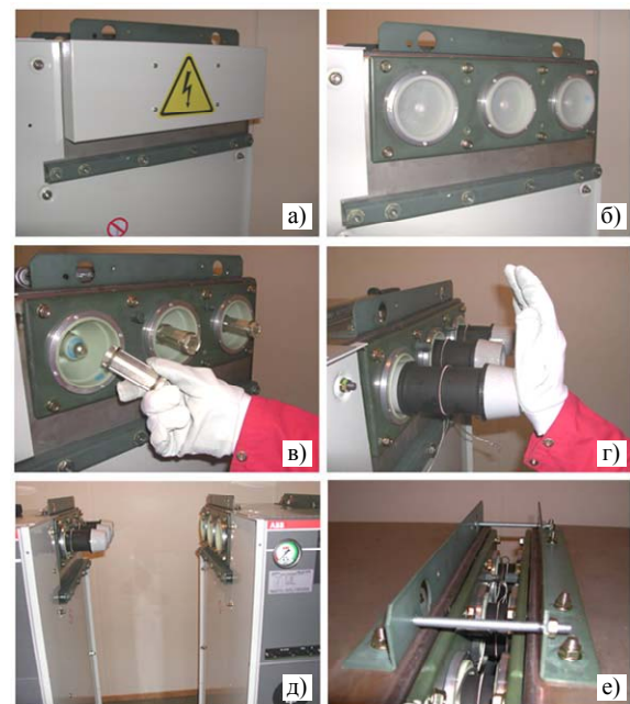
Рис. 23. Етапи з'єднання блоків за допомогою аксесуарів бокового розширення
