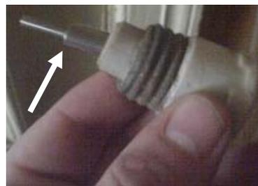
Рис. 1. Вечный "предохранитель"
