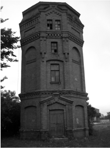
Рис. 5. Водогінна вежа 1890 року на залізничній станції «Зарудинці» залізничної гілки «Козятин – Погребище», с. Зарудинці (2009).
