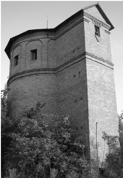
Рис. 6. Водогінна вежа 1958 року на території закинутого і зруйнованого тваринницького комплексу, селище Звиняче (2009)
