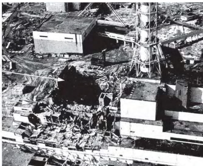
Рис. 1. Разрушенный 4-ый блок ЧАЭС (май 1986 г.).
