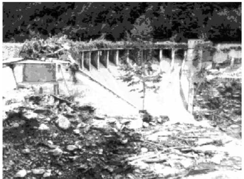
Рис. 1. Надзвичайна ситуація на арковій греблі Палагнедра на р. Мелецца (Швейцарія, 8 серпня 1978 р.). Відбулося катастрофічне блокування лісоматеріалом водозливів греблі, яке призвело до переливу води через гребінь споруди, висотою 72 м [6]
