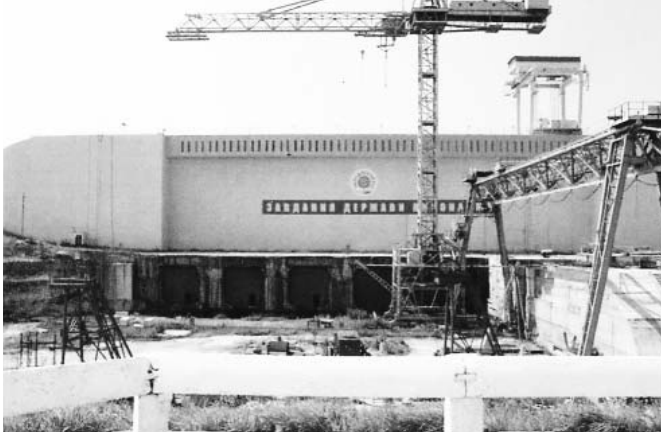
Будівництво Дністровської ГАЕС Каховська ГЕС
