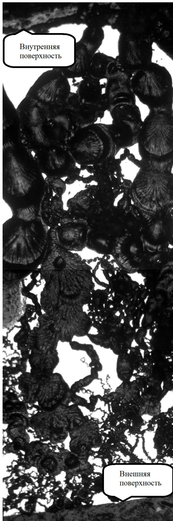
Рис. 3. Коррозия по цепочкам включений через стенку трубы
