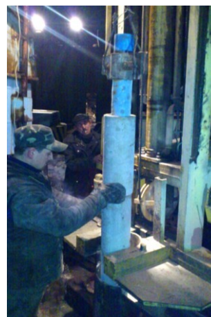
Рис. 6. Спуск КГФ в скважину
