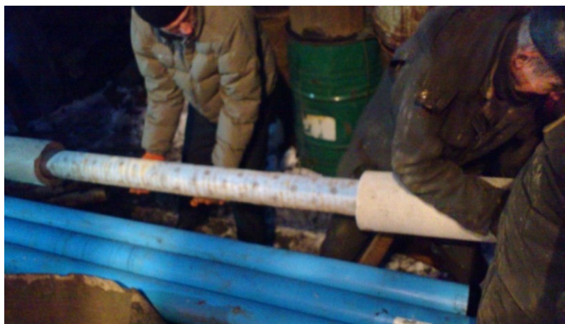
Рис. 5. Процесс сборки КГФ
