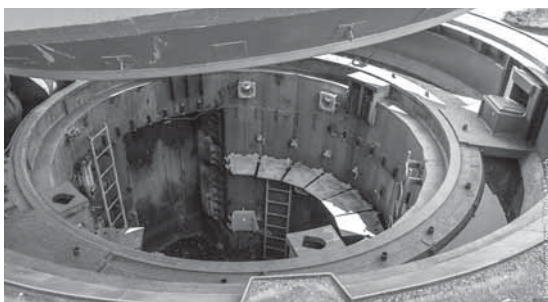
Рис. 6. Шахта для размещения МБР
