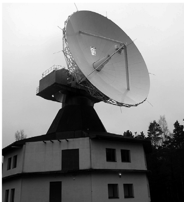
Рис. 1. Внешний вид телескопа VIRAC РТ-16. В ходе проведенной модернизации в 2015 г. металлическая антенна заменена на углепластиковую, в результате существенно снизился вес подвижной части телескопа и значительно улучшилась точность отражающей поверхности
