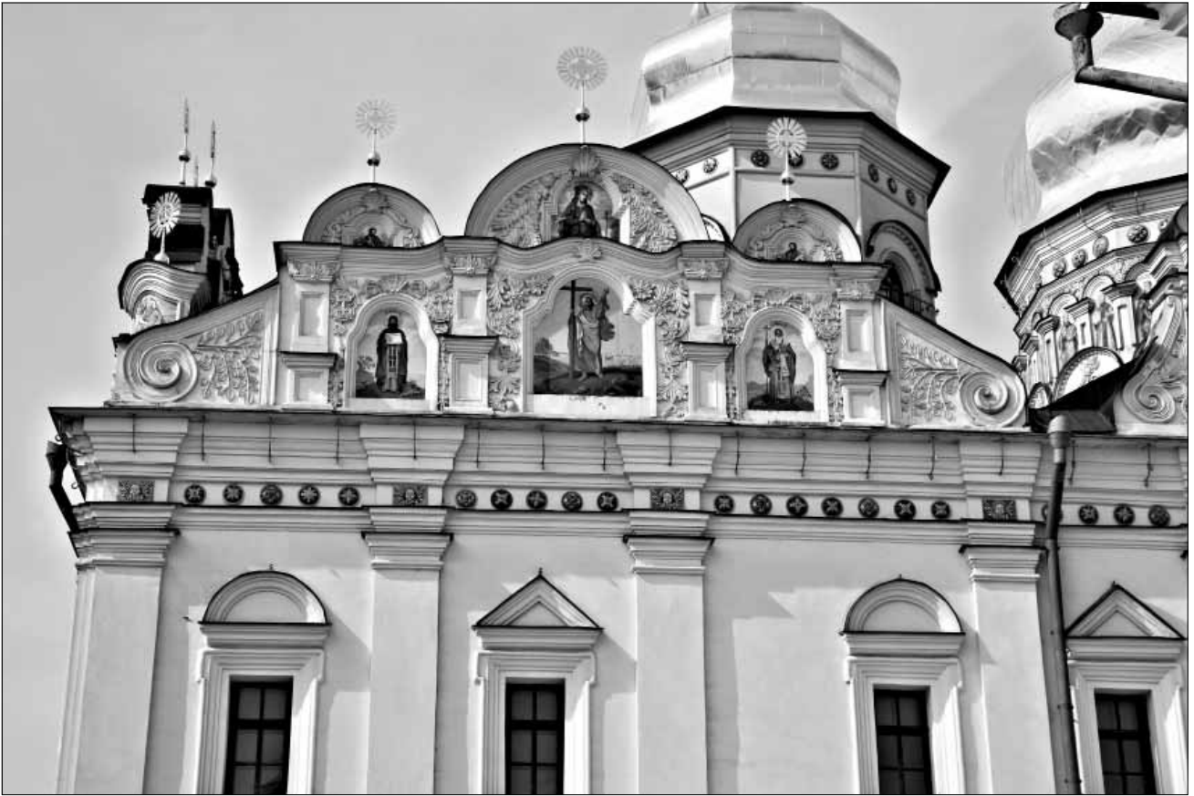
Рис. 6. Низки керамічних розеток на фасадах і банях відбудованого Успенського собору Києво-Печерської лаври
