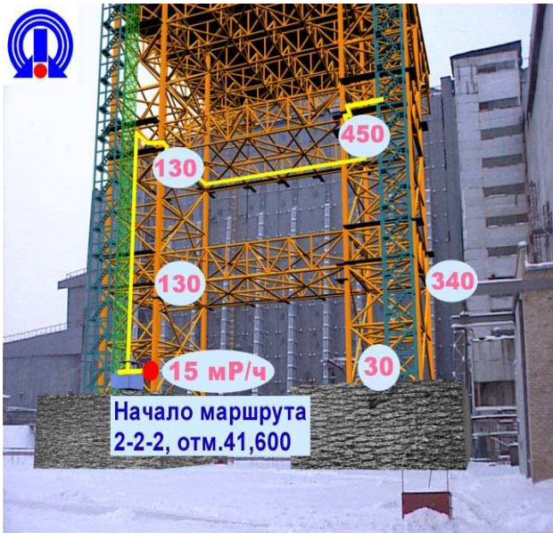
Рис. 3. Проектируемые металлоконструкции усиления западного фрагмента „Укрытия”.
