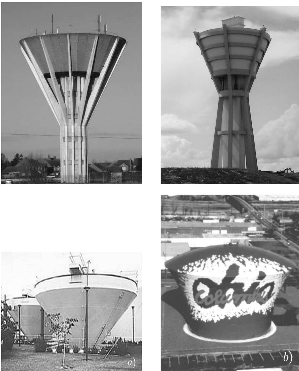
Рис. 1. Типичные конические водонапорные баки (сверху) и нефтехимические резервуары на Аляске и в Огайо (внизу)
