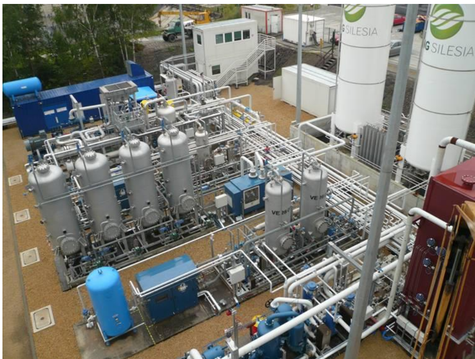
Рис. 8. Демонстрационная установка на шахте Krupinski, Польша
