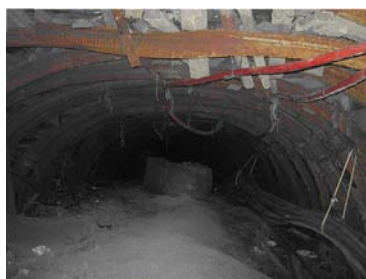
Рис. 3. Образование клина выдавливания пород кровли и почвы в условиях шахты «Белозерская»
