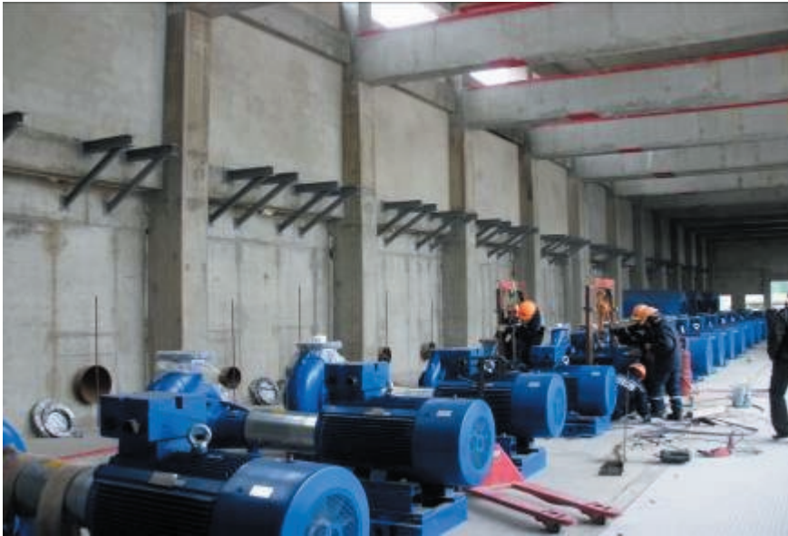
Рис. 3. Монтаж оборудования комплекса водоподготовки
