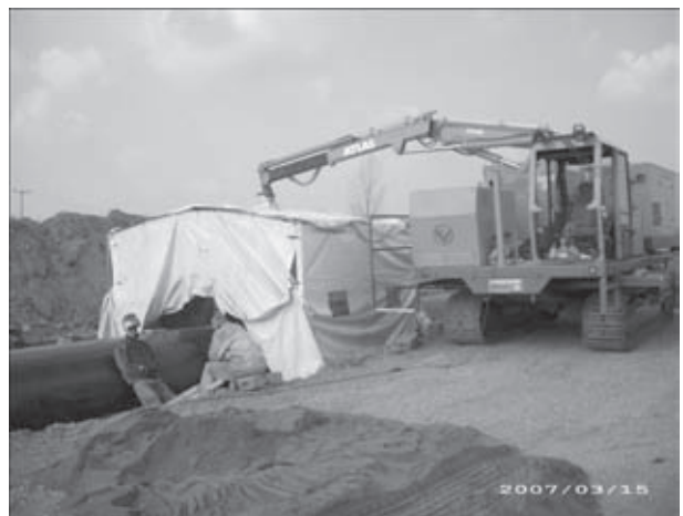
Рис. 1. Монтажная площадка для прокладки трубопровода
