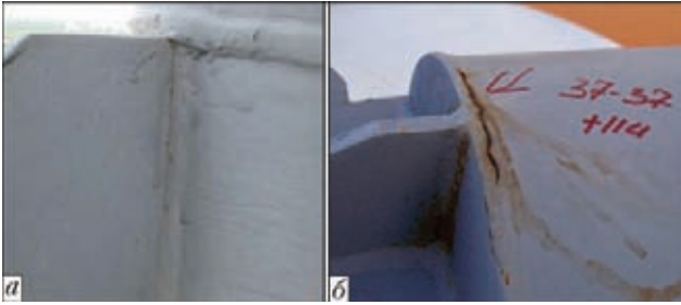
Рис. 1. Примеры развития трещин в узлах раскосов башни (а, б — см. в тексте)
